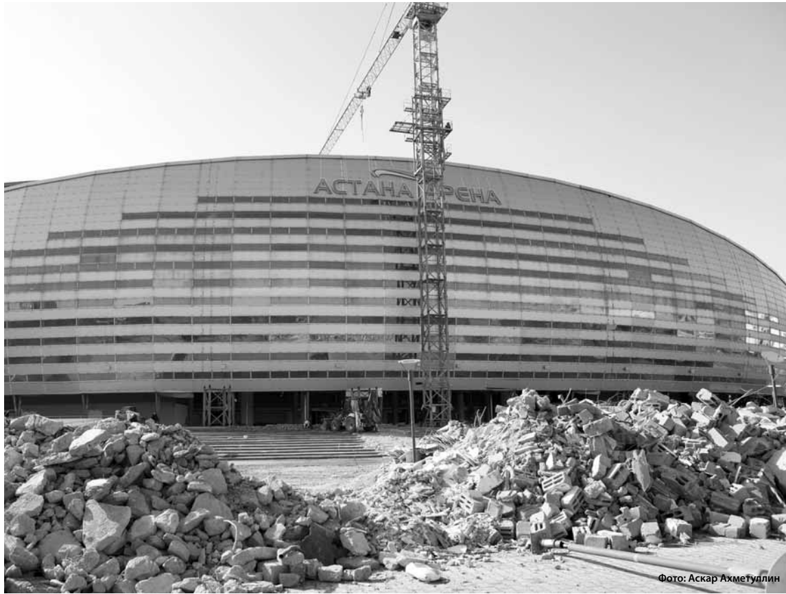
Реконструкция стадиона «Астана Арена».
